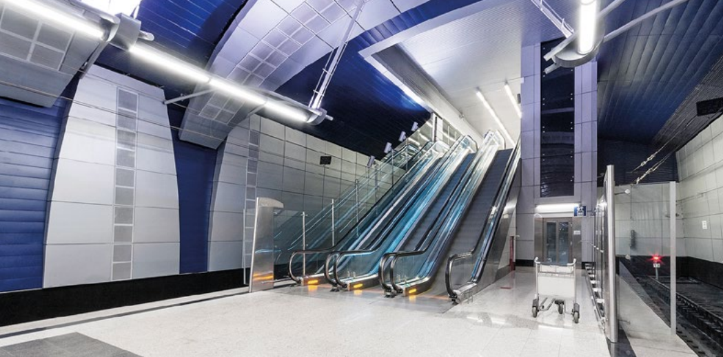
эскалатор железнодорожной станции Аэропорт Внуково escalator at Vnukovo Airport Train Station
