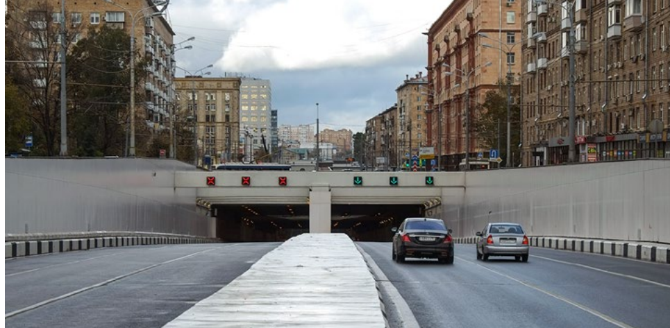
въезд в Алабяно-Балтийский тоннель entrance to Alabyano-Baltic Tunnel
