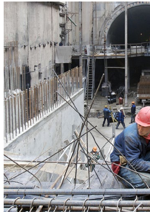
фото строительства construction in progress
