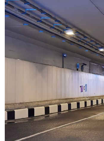
Лефортовский тоннель Lefortovo Tunnel
