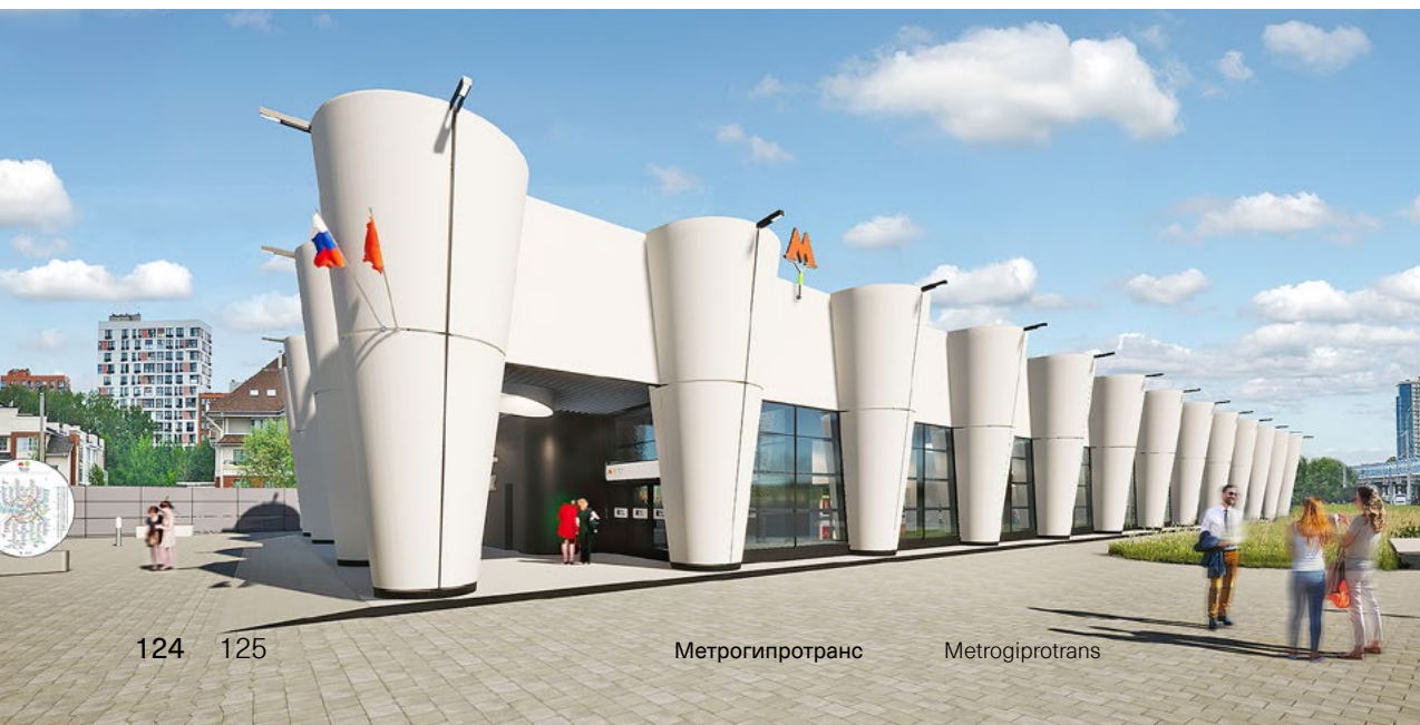
вестибюль станции «Физтех» lobby of Fiztek Station
