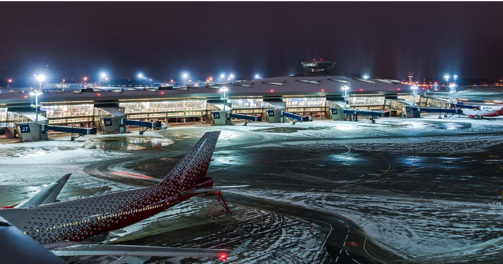
ночной вид выходов на посадку gates at night
