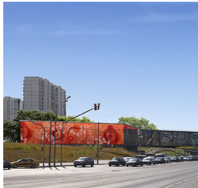
станция «Мичуринский Проспект» Michurinsky Prospekt Station
