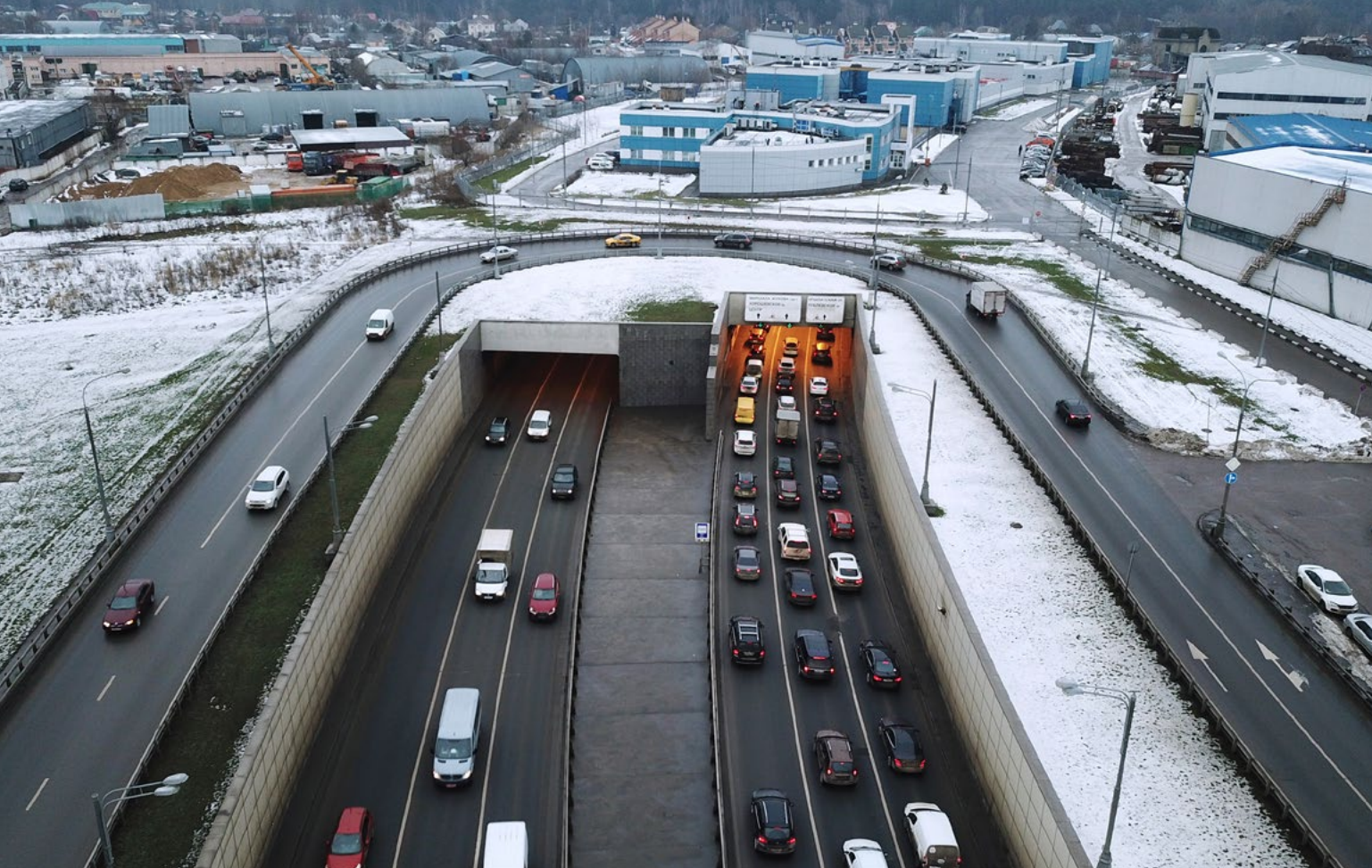
Северо-Западный тоннель Northwestern Tunnel
