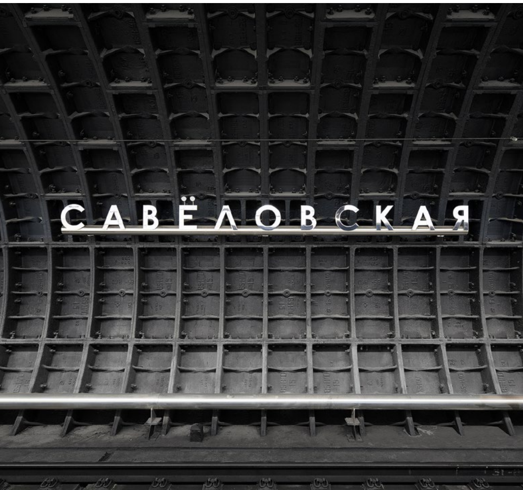
путевая стена tunnel wall
